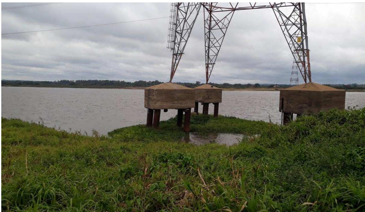
Por tal motivo la estructura ha perdido verticalidad y no ofrece en la actualidad seguridad operativa debiendo realizarse refuerzos en la estructura y tendidos de riendas para tratar asegurar su estabilidad y evitar su desmoronamiento.
